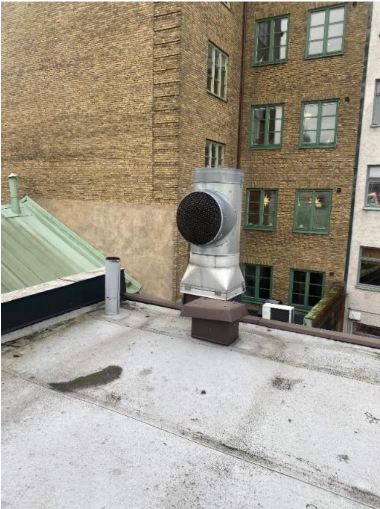
Figur 4.10 Källa nr. 11 placerad på tak inom fastigheten Inom Vallgraven 56:1
