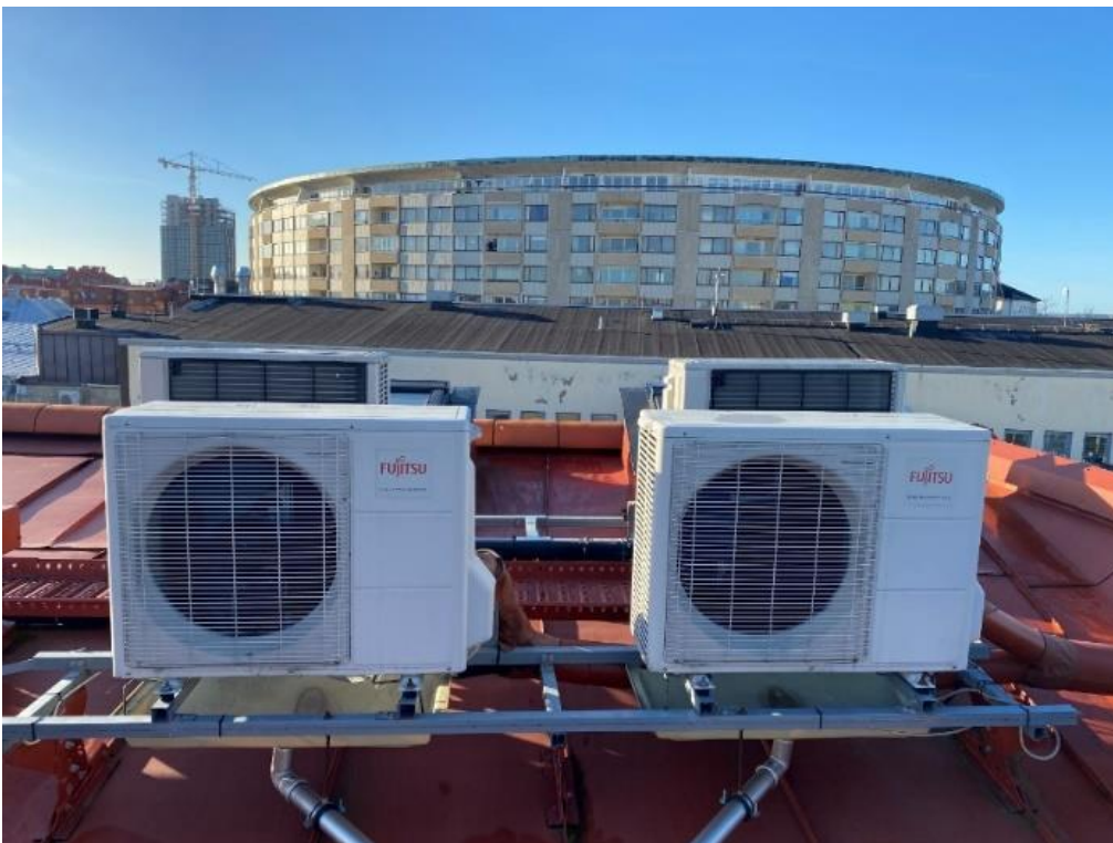
Figur 4.17 Källa nr. 19-22 placerade på tak inom fastigheten Inom Vallgraven 56:3
